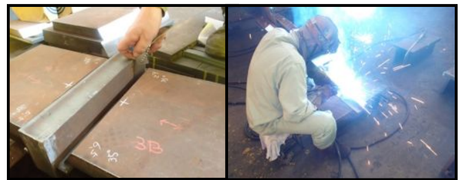
写真1 試験体製作状況
